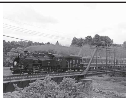
東武鉄道砥川橋梁
