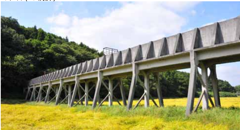
膳棚水路橋の全景
