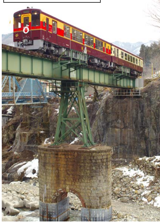
①第一松木川橋梁
